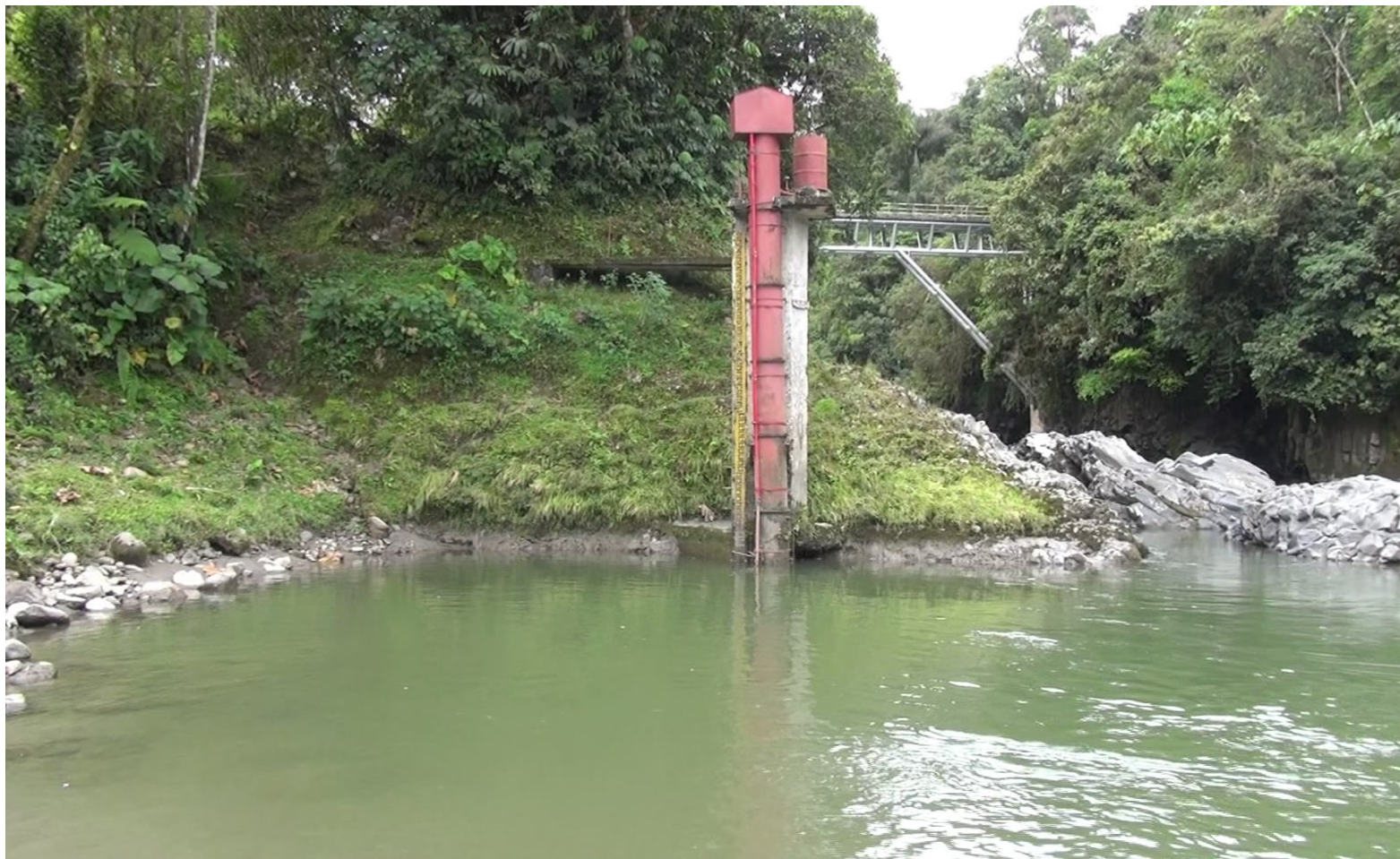
Фото 067 Водомерный пост на мосту Bombo, Кихос
